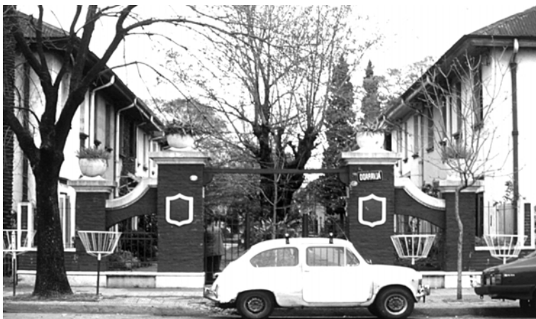
Portal de entrada del barrio “Arzobispo Espinoza”, construido con fondos de la colecta nacional promovida por grupos católicos. Barrio San Vicente de Paul. (Archivo personal del autor)
